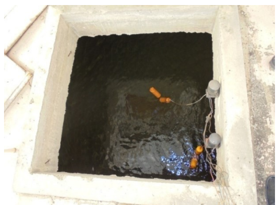
ภาพที่ 4-5 ถึงสำรองน้ำใต้ดิน เปลี่ยนอุปกรณ์ข้อต่อต่างๆ และอยู่ในสภาพดี ไม่มีรั่วซึม และถึงสำรองน้ำขึ้นดาดฟ้า
