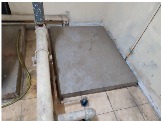
ภาพที่ 4-5 ถึงสำรองน้ำใต้ดิน เปลี่ยนอุปกรณ์ข้อต่อต่างๆ และอยู่ในสภาพดี ไม่มีรั่วซึม และถึงสำรองน้ำขึ้นดาดฟ้า
